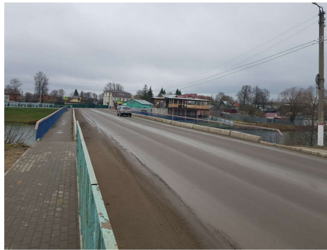
Вид на проезжую часть
