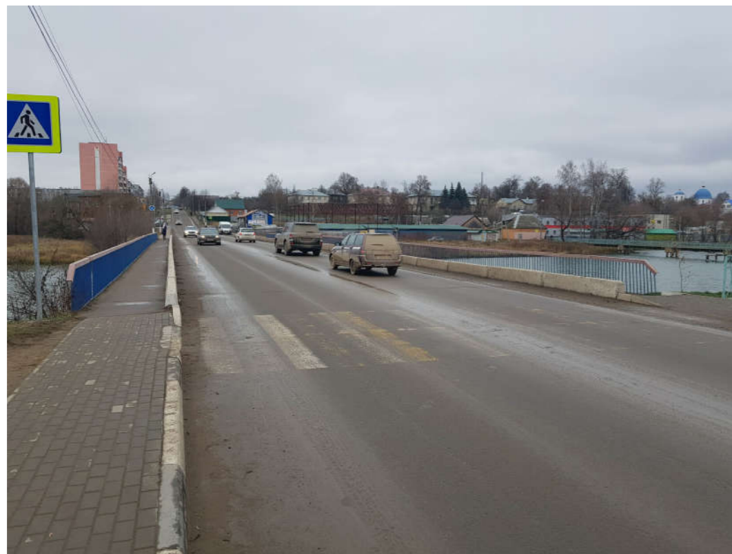
Вид на проезжую часть
