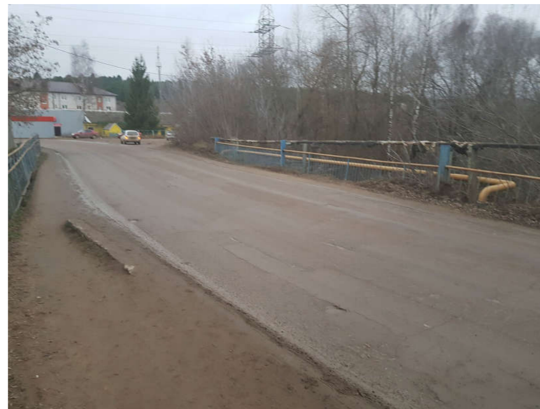
Вид на проезжую часть
