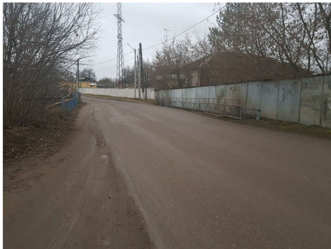
Вид на проезжую часть
