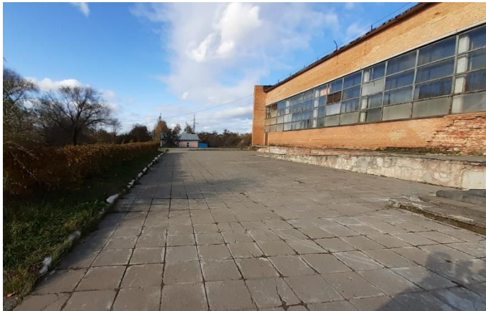
Вид плитки возле бетонного крыльца ДК
